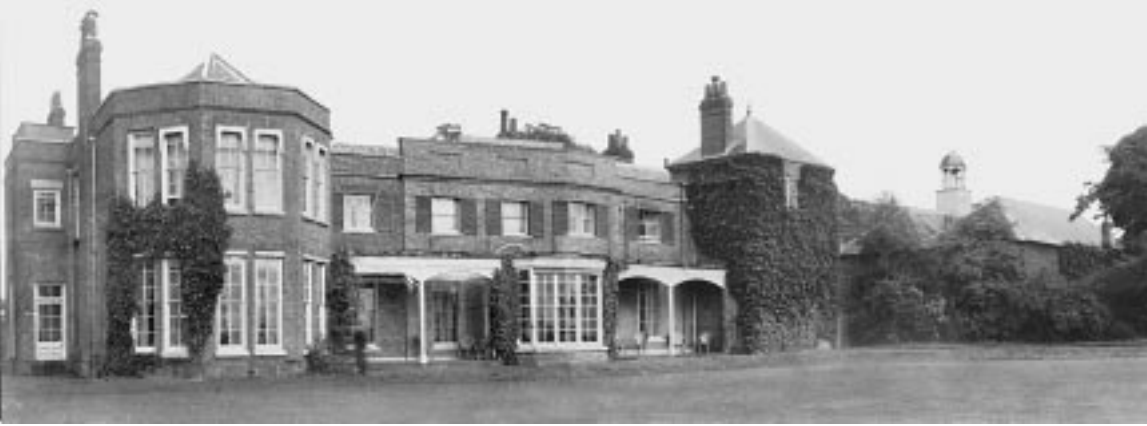
Oakley House, Bromley Common, Kent, England; Internationale Hauptstelle 1932-3
